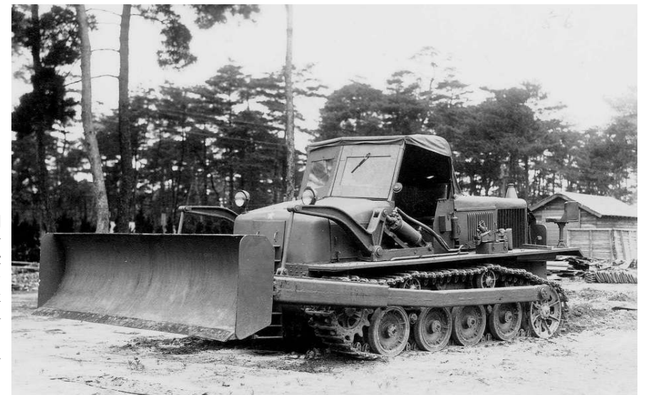
写真11-9 小松製作所試作「トヘ車」軍用ブルドーザ (1945年) (コマツ所蔵写真 97) ) アメリカ軍の飛行場建設の機械化部隊に対抗するためにブルドーザの製作命令があり、4種類の大砲けん引車がブルドーザに改造されて、あわせて80台が生産されている。柔らか過ぎるクローラのため土を押し作業には向いていなかったようである。
