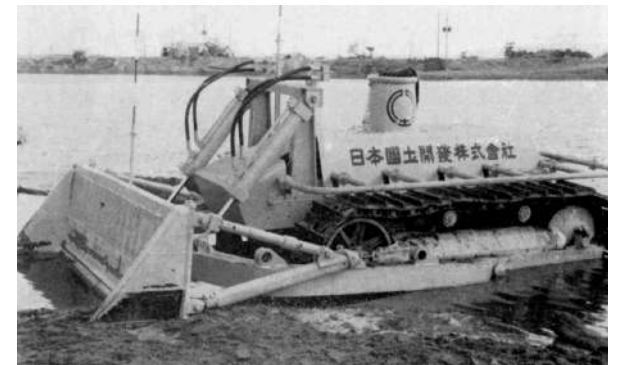
写真13-8 日本国土開発水中ブルドーザ (1968年) (日本建設機械化協会所蔵写真 133 ) 世界初の水中ブルドーザ試験車である。陸上のエンジンで油圧ポンプを回し、陸上からの長い油圧ホースで動力を伝える。
